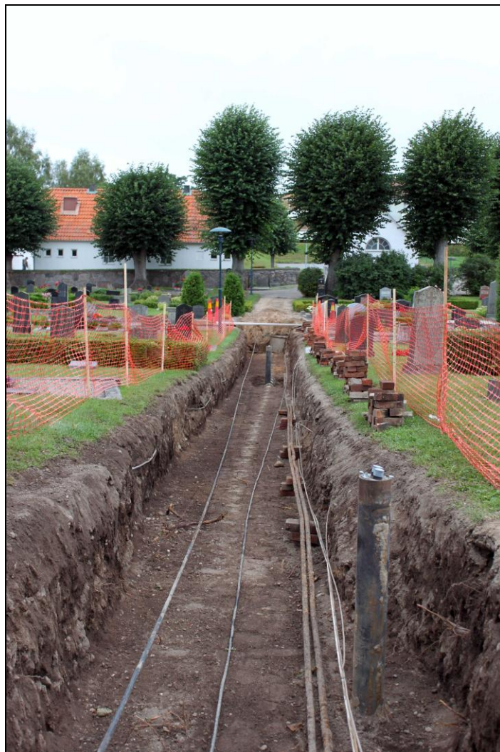
Överblick kabelschakt, fotografi mot NV.
