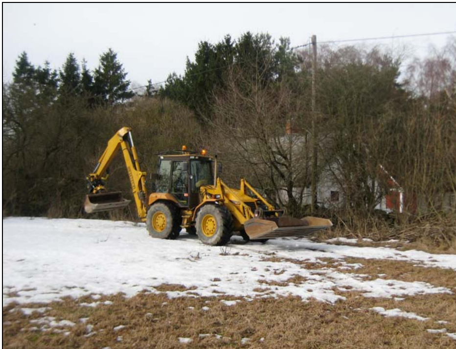
Fig.2 - Inför dragning av Schakt 14 .
